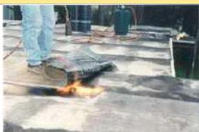
La fase di lavoro consiste nello stendere i teli d'impermeabilizzazione su copertura piana o inclinata per la saldatura, a mezzo fiamma, al sottofondo predisposto con mano di bitume a freddo.
