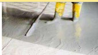
Trattasi della realizzazione di massetti in calcestruzzo semplice o alleggerito per sottofondo di pavimenti, formazione di pendenze, ecc.
