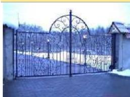
Trattasi della verniciatura di opere in ferro, previa accurata carteggiatura e spolveratura, applicazione di fondo antiruggine e di smalti sintetici o a base di ossido di ferro, eseguita a pennello.
