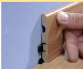
Trattasi della posa in opera di battiscopa o zoccolino di diverso materiale, quale marmo, pietra, grès, clinker, ceramici in genere, in funzione del pavimento o di valutazioni estetiche. L'altezza minima del battiscopa è di cm 8-10 e si posa a pavimento ultimato, usando malta di cemento o collante specifico.
