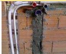
Realizzazione di un impianto sottotraccia, ossia di un impianto generalmente elettrico, telefonico, ecc., inserito nella muratura e non visibile all'esterno.
