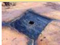
Trattasi della rimozione di manto impermeabilizzante su lastrici solari o coperture inclinate, che consiste nello smantellamento dei vari strati di guaina preesistenti, l'abbassamento delle macerie al piano di carico e il trasporto in discarica del materiale di risulta.
