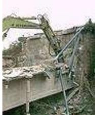
Trattasi della demolizione di elementi strutturali in c.a. (travi, pilastri, setti, ecc.) eseguita con l'ausilio di mezzi meccanici.
