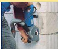
Trattasi della formazione di tracce in muratura di qualsiasi natura per l'alloggiamento di tubazioni in genere, compreso la chiusura al grezzo delle tracce stesse.
