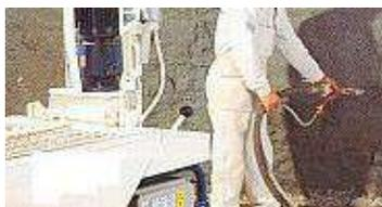
Trattasi dell'applicazione di intonaci interni su superfici verticali e/o orizzontali mediante l'utilizzo di macchina intonacatrice. L'intonaco civile interno viene applicato come elemento protettivo e decorativo delle superfici murarie interne, in quanto l'umidità, la condensa e la presenza di microrganismi nelle superfici murarie rendono necessaria la loro protezione e manutenzione.
