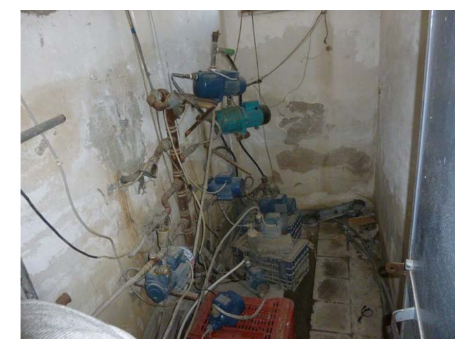
LOCALE PER AUTOCLAVE EDIFICIO B
