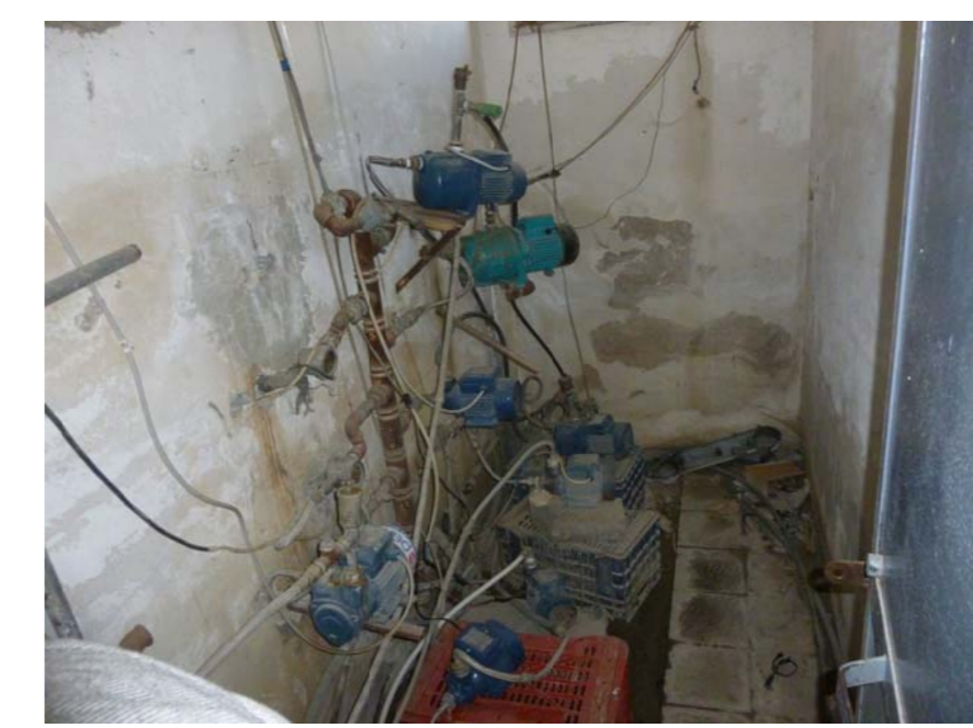
LOCALE PER AUTOCLAVE EDIFICIO B
